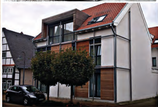
Ritterstrasse 2 um 1900 / Neubau 2020
